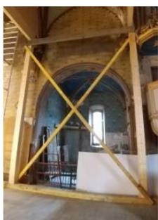
Cette année a vu la réalisation d'un **deuxième étalement**, celui **de l'arc situé au-dessus de l'entrée principale de la chapelle, côté ouest**. Jugé nécessaire par les « hommes de l'art », dès la réception du 1<sup>er</sup> étalement, en octobre 2021, il a été réalisé fin juin 2022.
